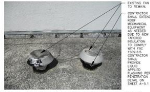
CC1 TYP. ROOF FAN FLASHING PHOTO
