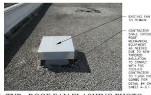
AA1 TYP. ROOF FAN FLASHING PHOTO
