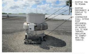
EE1 TYP. HOOD FAN FLASHING PHOTO
